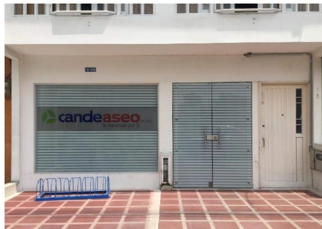
Sede principal, Cabecera Municipal Calle 10 N. 9-49 Barrio San Cristóbal
